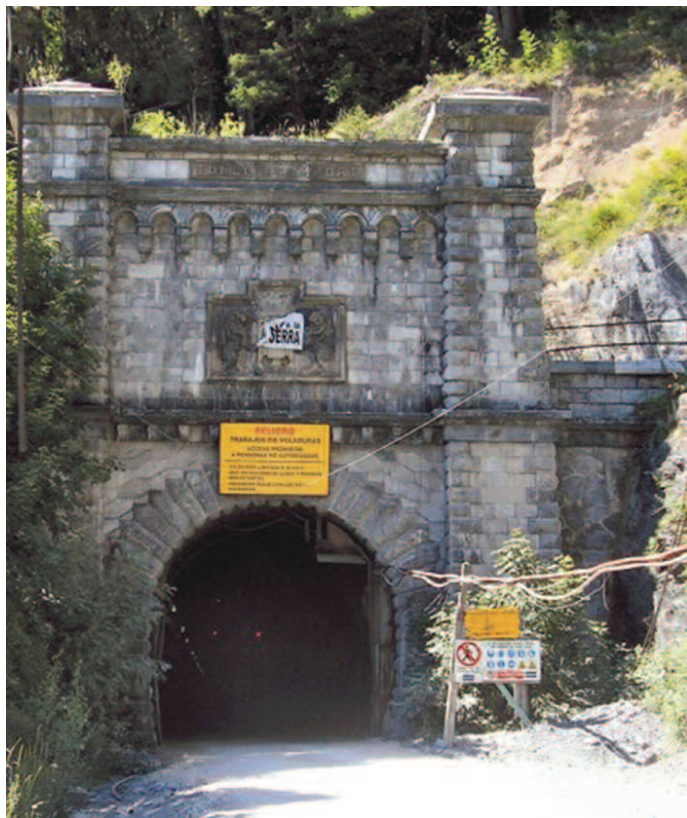
La tête sud du tunnel ferroviaire était conçue comme un monument : la porte de l'Europe. Actuellement elle est transformée en tunnel routier de secours.
